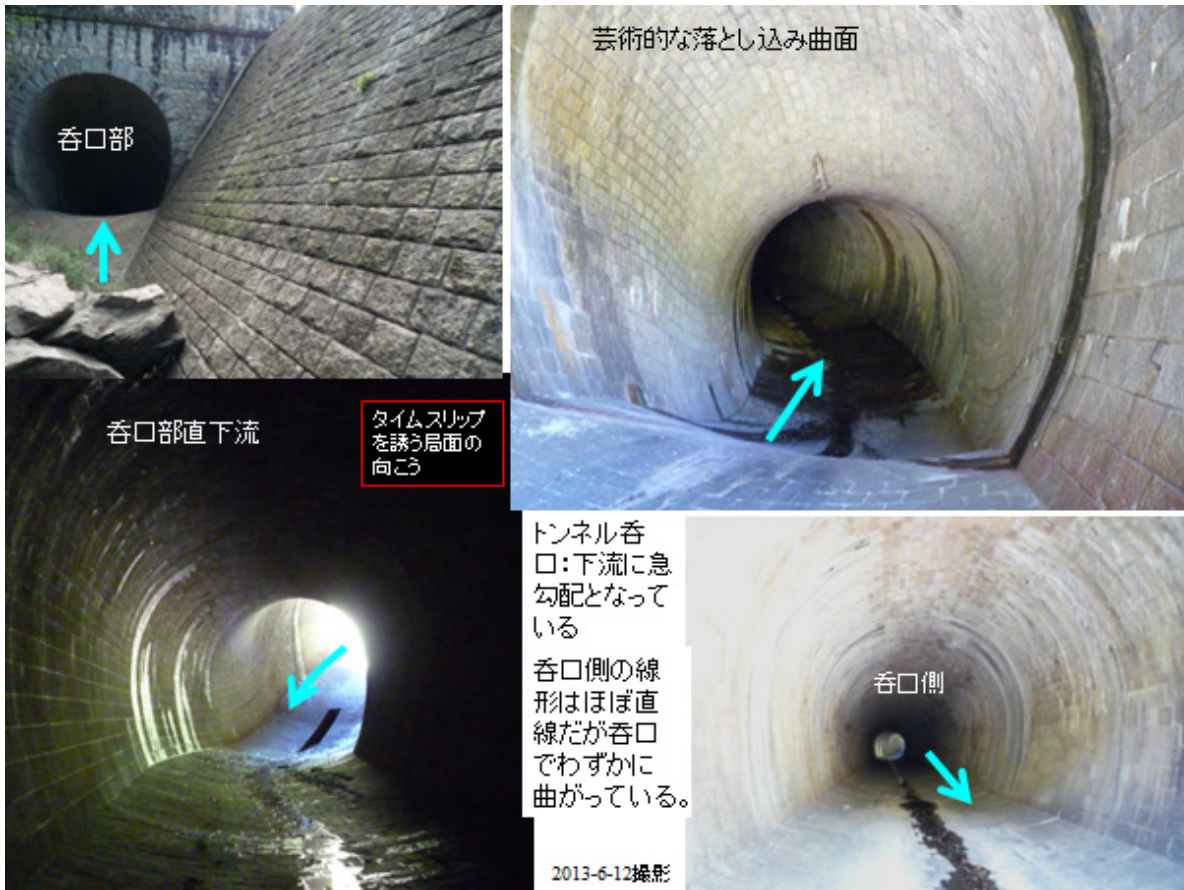
図 4 導水路トンネル呑口の形状
