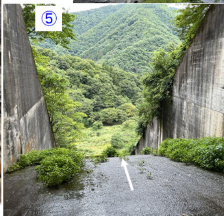
図 9 笹生川ダムトンネル洪水吐きの形状 2 流入部～導流部～減勢工
