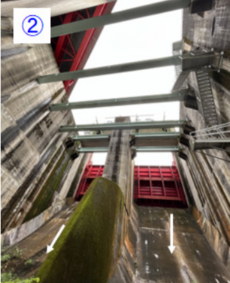
図 9 笹生川ダムトンネル洪水吐きの形状 2 流入部～導流部～減勢工
