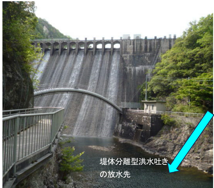
図 2 千苺ダムの堤体付属の全面越流式洪水吐き
