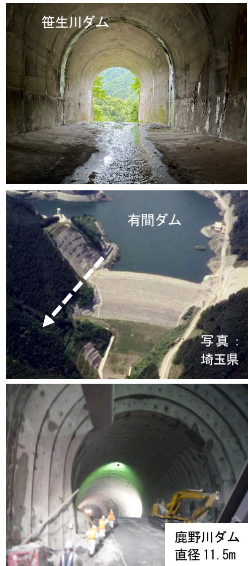
図1 トンネル洪水吐き最近例
