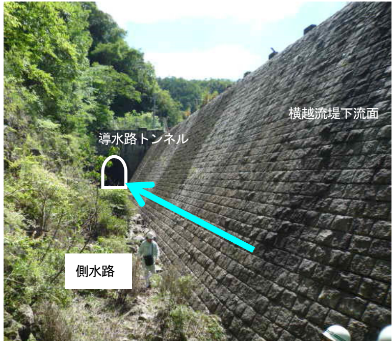
図 3 千苺ダム流入部 横越流堤～側水路～トンネル呑口 撮影 2013 年 6 月 12 日
