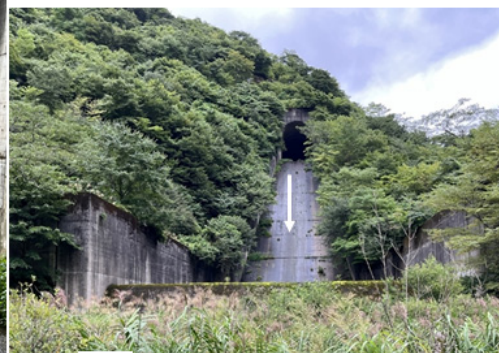
図 9 笹生川ダムトンネル洪水吐きの形状 2 流入部～導流部～減勢工
