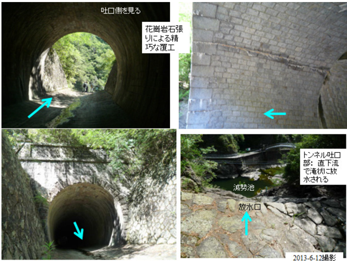
図 5 導水路トンネル吐口の形状
