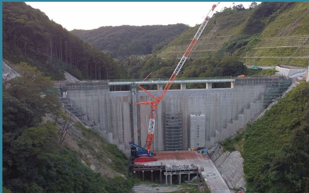
本体打設を終えた「島根県 波積ダム」 (上流面を望む 令和4年9月22日撮影)
