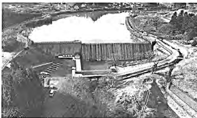
（プロジェクト名）千本ダム堤体補強工事
